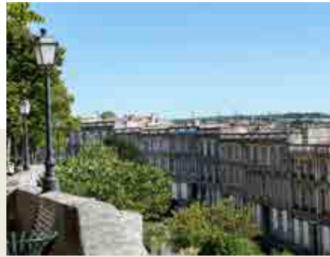
► Balustrades, rue Waldeck Rousseau
